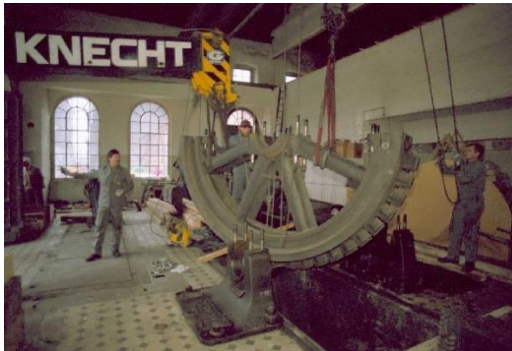
Bild: Revision Generator Ausbau
