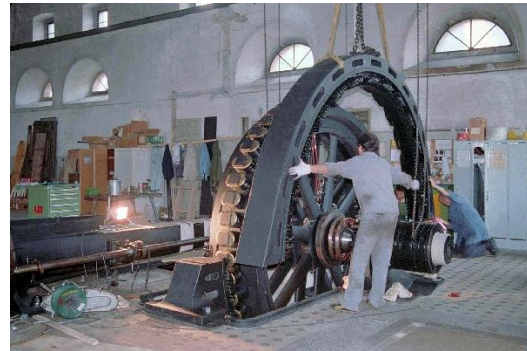
Bild: Revidierter Generator Einbau
